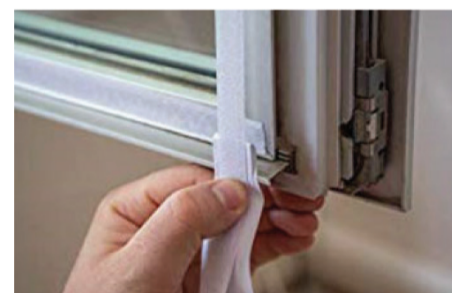
Рис. 8. З'єднайте кінці стрічки, щоб забезпечити повне ущільнення.
