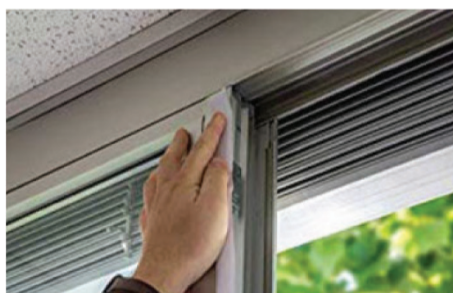
Рис. 5. Приклейте клейку стрічку з комплекту до рами
